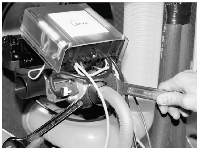
Fig. 60: collegamento della condotta del gas
