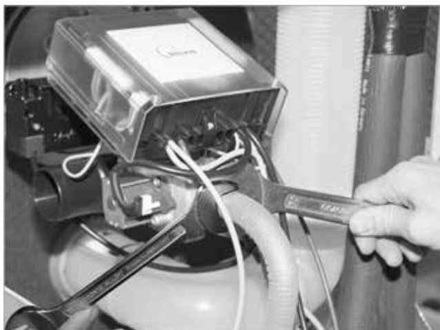
Fig. 60: collegamento della condotta del gas
