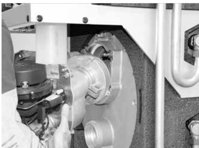
Fig. 70: Montaggio del bruciatore
