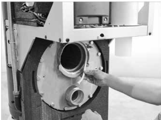
Fig. 64: Inserire il cordoncino di tenuta del bruciatore
