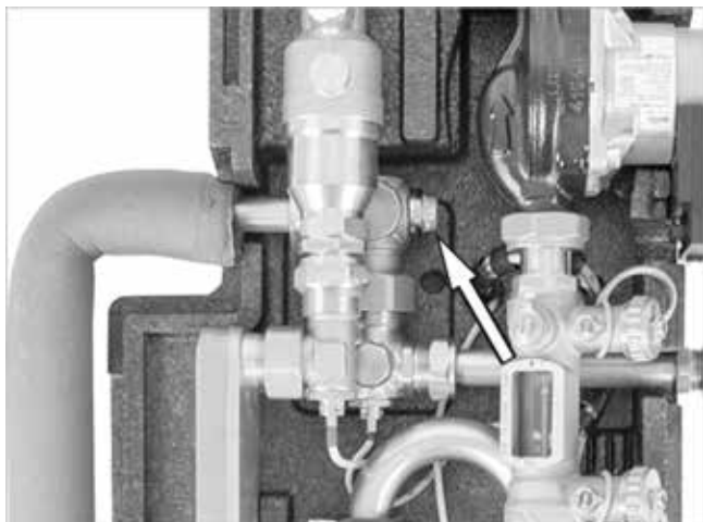
Fig. 17: Sfiatatoio manuale del lato secondario
