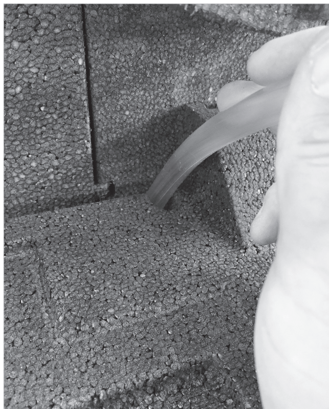
Fig. 8: Inserire il tubo flessibile a pressione
