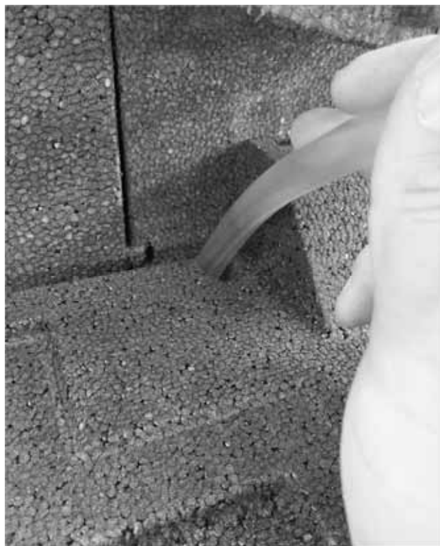
Fig. 8: Inserire il tubo flessibile a pressione
