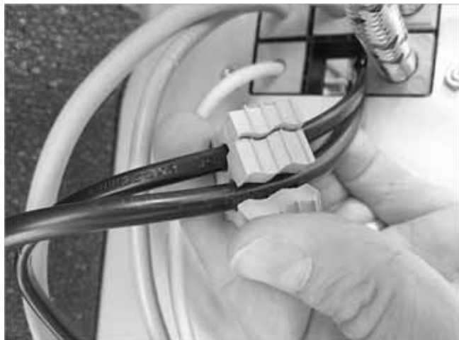
Fig. 13: Posizionamento del passaggio cavo attorno al cavo
