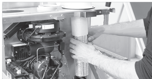
Afb.11: Inwendige geluidsdemper plaatsen
