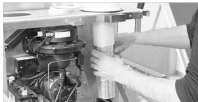
Afb.11: Inwendige geluidsdemper plaatsen
