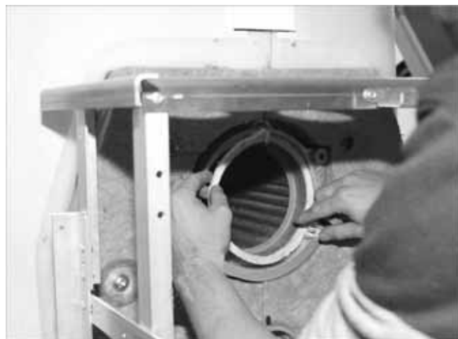
Afb. 1: Branderafdichtband plaatsen
