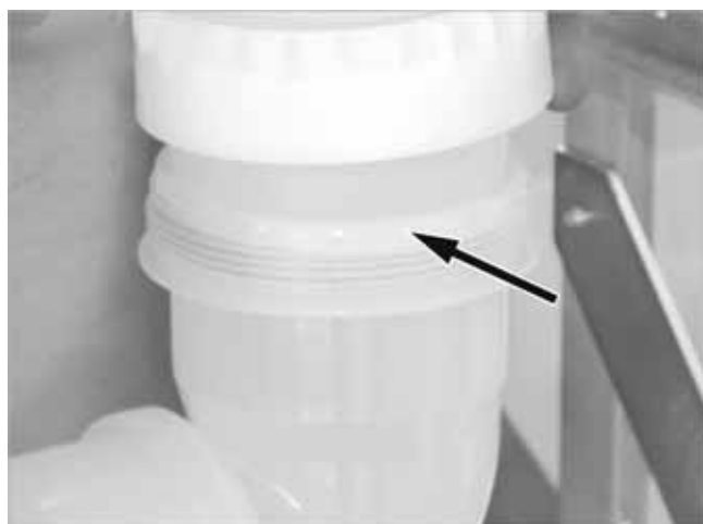
Afb. 15: De rookgasbocht recht uitgelijnd vastschroeven
