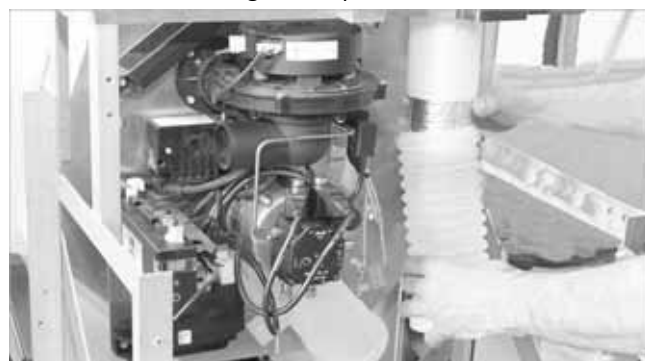
Afb.12: Rookgasaansluitstuk opsteken
