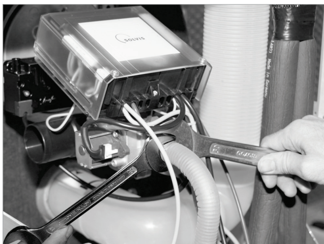
Fig. 60: Conectar la tubería de gas
