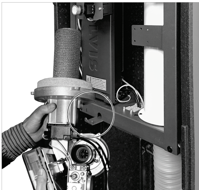
Fig. 141: Enganche del quemador en la consola (posición de mantenimiento)
