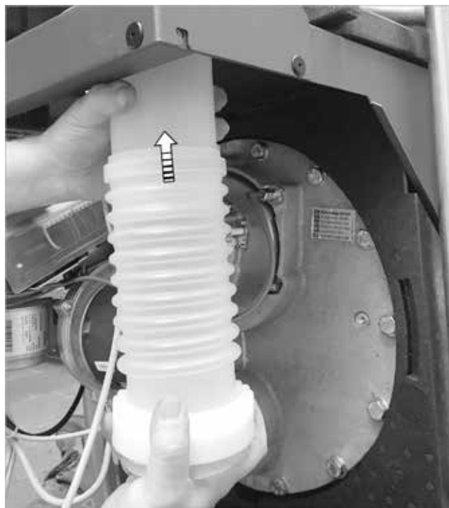
Fig. 88: Enchufe la pieza de conexión para la salida de humos en el tubo de salida de humos.
