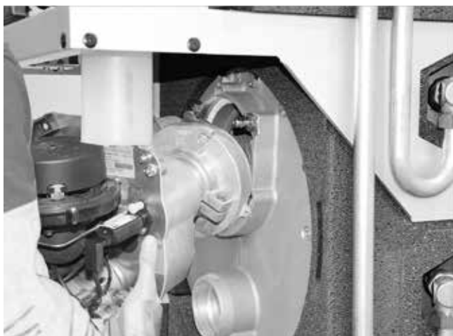
Fig. 70: Instalación del quemador
