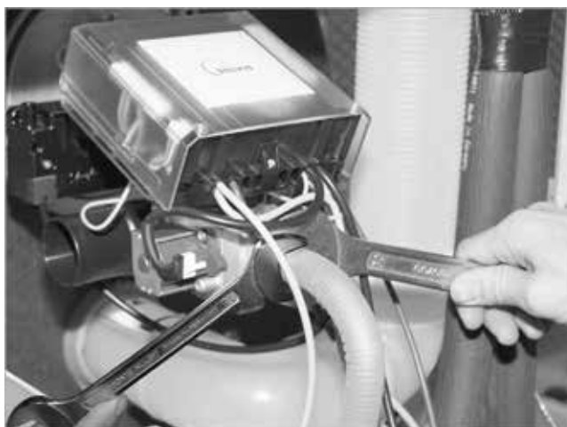
Fig. 60: Conectar la tubería de gas
