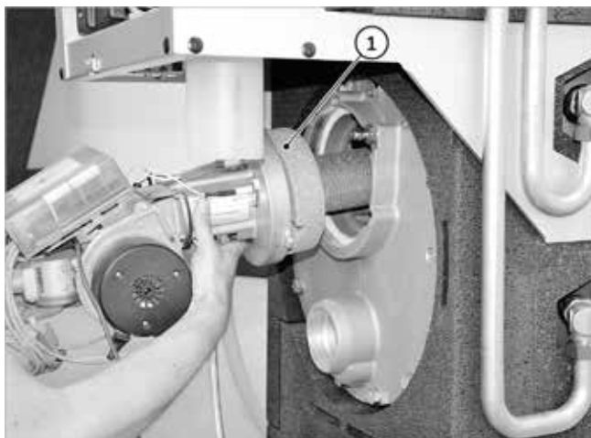
Fig. 49: Instalación del quemador
