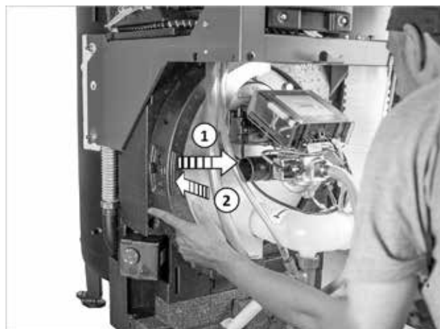
Fig. 100: Montaje del aislamiento delantero de la brida
