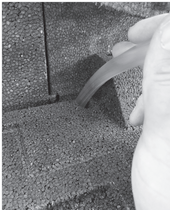
Fig. 8: Paso del tubo flexible de presión
