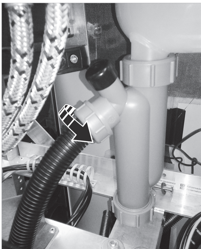
Fig. 17: Colocación del tubo de condensación (SolvisMax)
