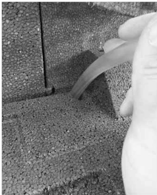
Fig. 8: Paso del tubo flexible de presión
