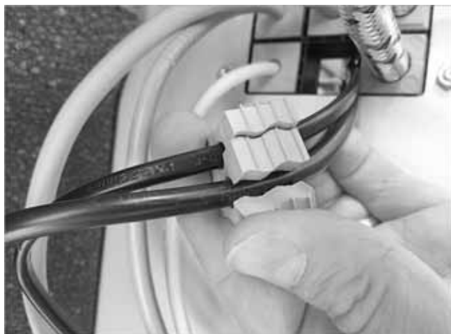
Fig. 13: Colocación del paso de cables alrededor del cable
