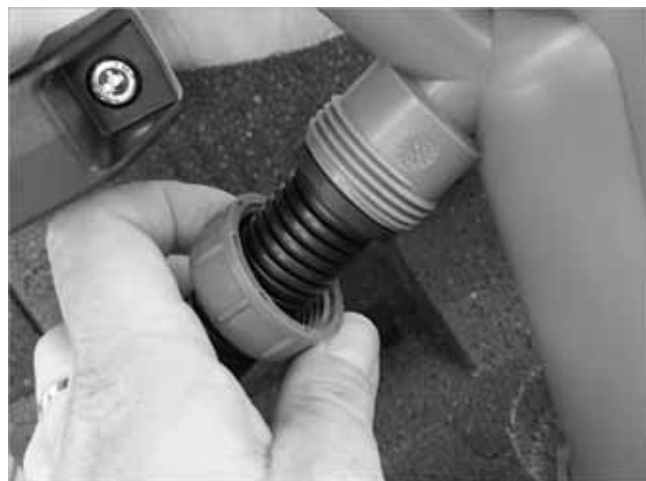
Fig. 5: Colocación del tubo de condensación (SolvisBen)
