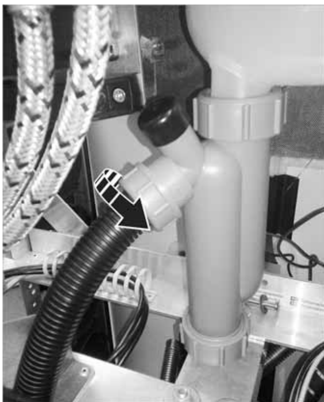
Fig. 17: Colocación del tubo de condensación (SolvisMax)
