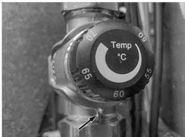
Fig. 60: Ajuste TMV
