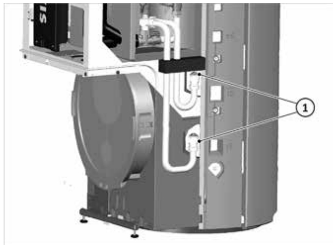
Afb. 30: De aansluitingen van de HKS controleren/vastdraaien
