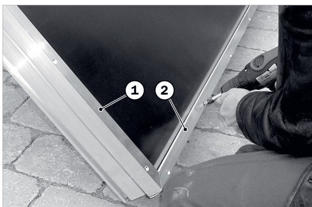
Fig. 34: Colocar, orientar y atornillar perfiles de clip
