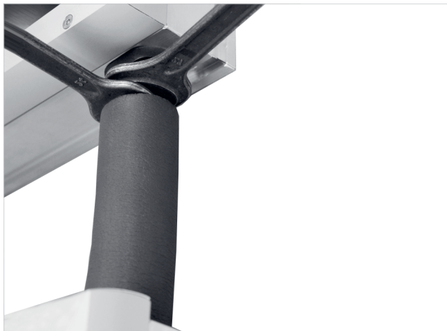
Fig. 60: Atornillar el VB-F-S-D-UE en la conexión superior
