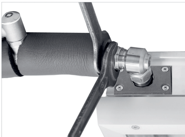
Fig. 57: Conexión superior: Avance solar
