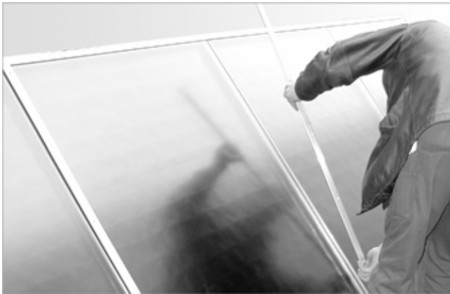
Fig. 37: Montar los listones protectores entre colectores
