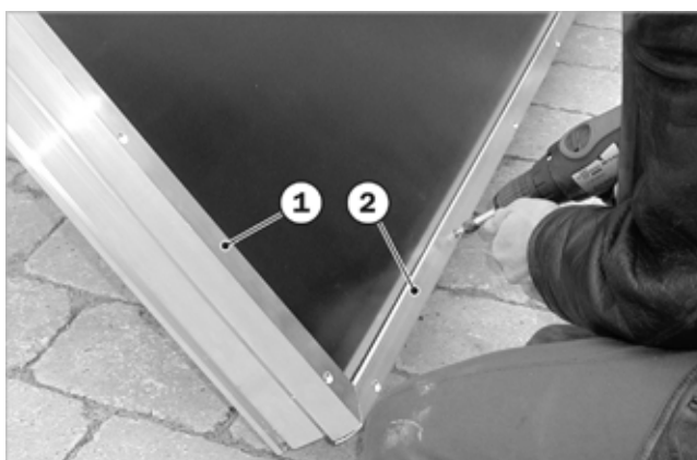
Fig. 34: Colocar, orientar y atornillar perfiles de clip
