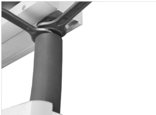
Fig. 60: Atornillar el VB-F-S-D-UE en la conexión superior
