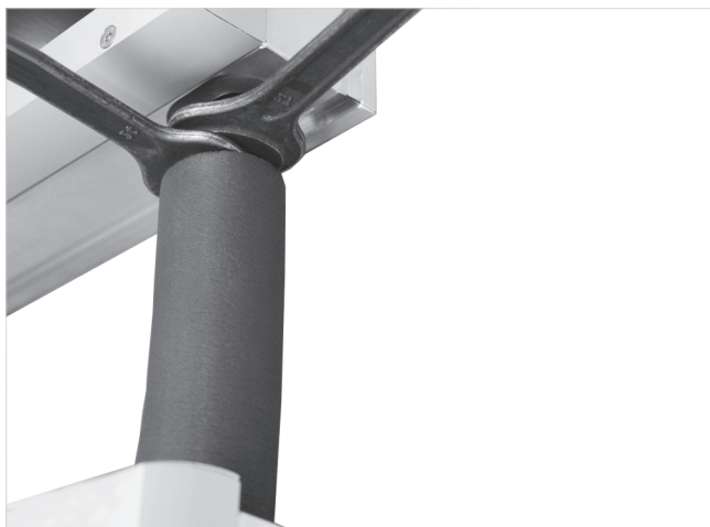
Fig. 73 : VB-F-S/D-UE vissé au raccord supérieur
