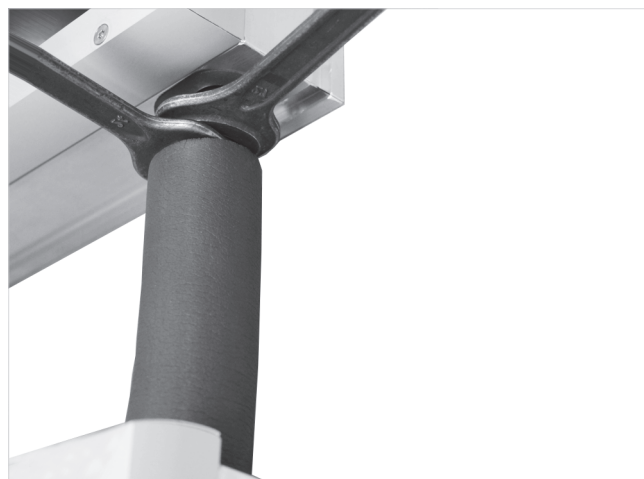
Fig. 64 : VB-F-S/D-UE vissé au raccord supérieur
