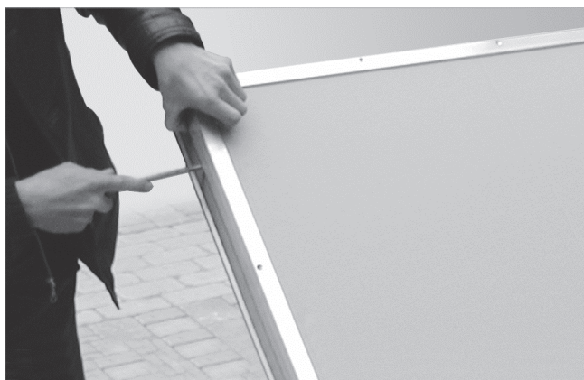
Fig. 33 : retrait des profils à clip et des cartons de protection
