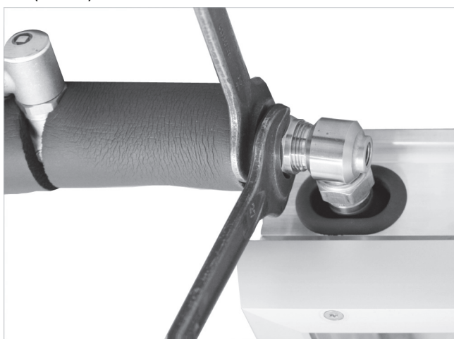
Fig. 61 : raccord du haut : aller solaire
