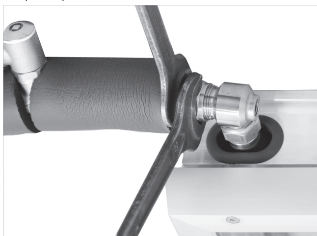
Fig. 70 : raccord du haut : aller solaire
