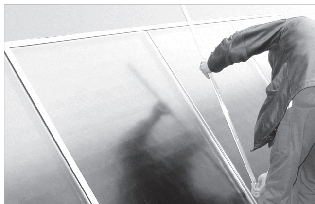
Fig. 38 : montage des baguettes de finition des entretoises
