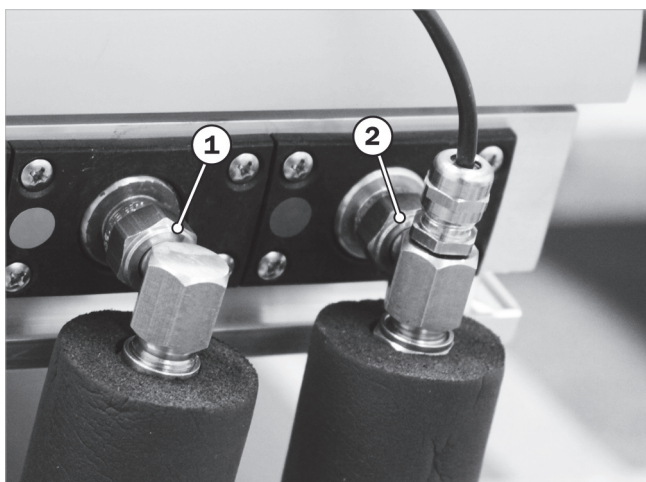
Fig. 84 : sonde d'immersion montée, SolvisFera Integral
