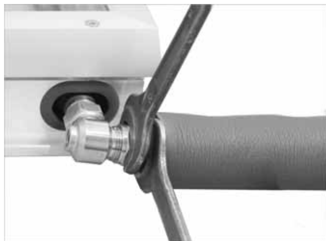
Fig. 75 : raccord du bas : aller solaire
