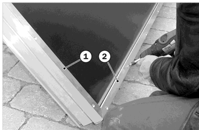
Fig. 35 : pose, ajustement et vissage des profils à clip
