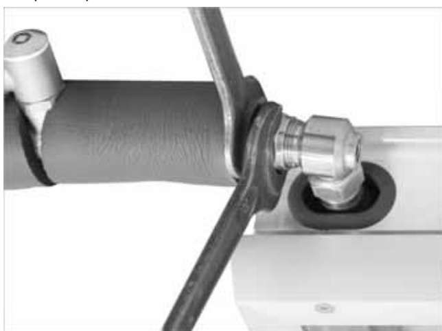
Fig. 61 : raccord du haut : aller solaire
