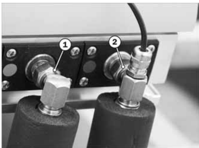
Fig. 84 : sonde d'immersion montée, SolvisFera Integral
