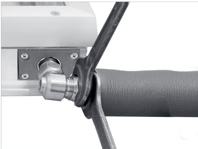
Afb. 62: Onderste aansluiting: Zonnesysteemaanvoer
