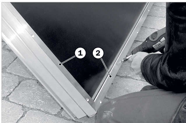
Afb. 34: De klemprofielen aanbrengen, uitlijnen, vastschroeven
