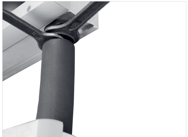
Afb. 69: VB-F-S-D-UE op de bovenste aansluiting schroeven
