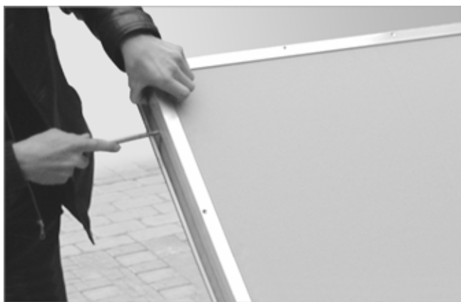
Afb. 32: Klemprofielen en afdekkarton verwijderen
