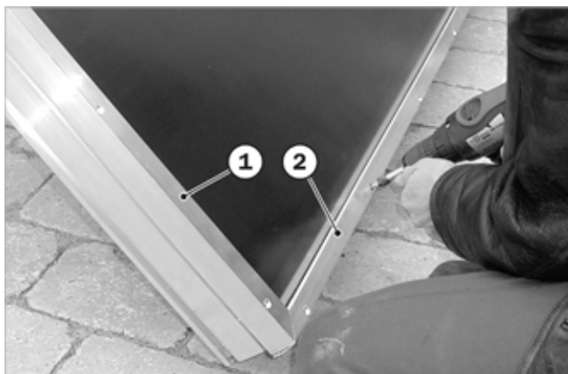
Afb. 34: De klemprofielen aanbrengen, uitlijnen, vastschroeven
