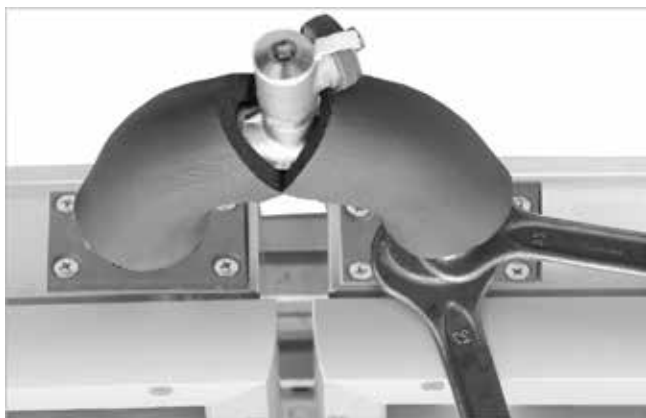
Afb. 64: Verbinding van de collectoren naast elkaar
