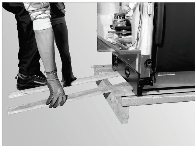
Abb. 7: Verschlagbretter an Rampe legen
