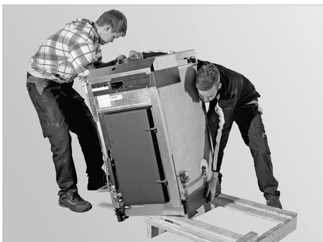
Abb. 9: Kessel von Palette schieben
