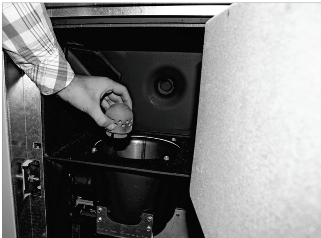
Abb. 149: Primärluftdorn entnehmen
