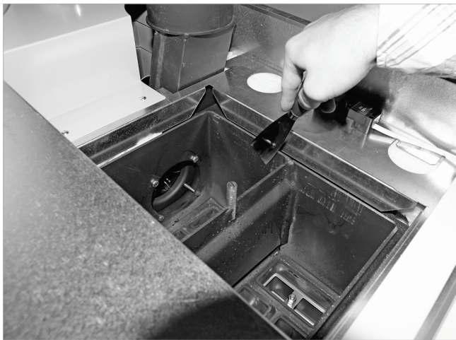
Abb. 160: Nachheizflächen reinigen
