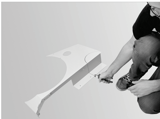
Abb. 75: Nur bei Abgasanschluss nach oben ausbrechen
