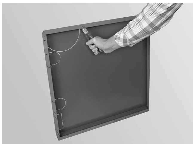
Abb. 94: Nur bei Abgasanschluss nach oben ausbrechen
