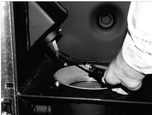
Abb. 142: Fallrinne reinigen
