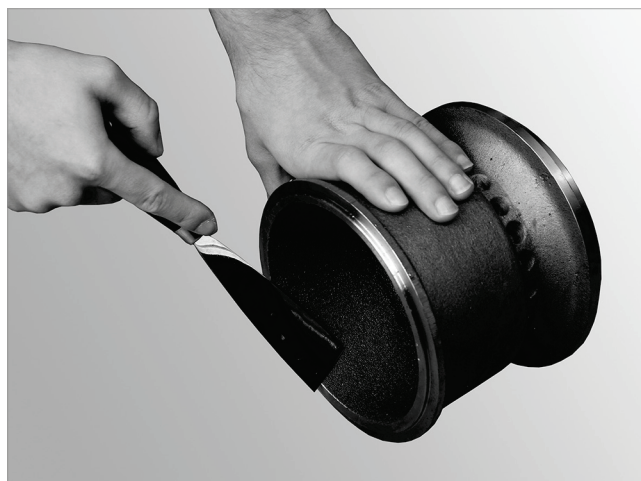
Abb. 147: Konus mit Spachtel reinigen
