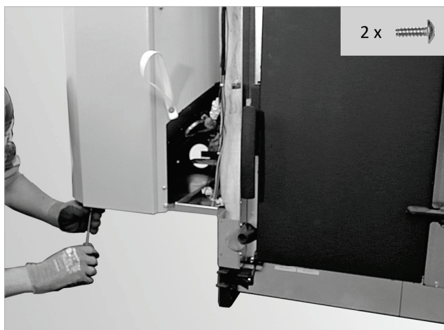
Abb. 39: Blende befestigen
