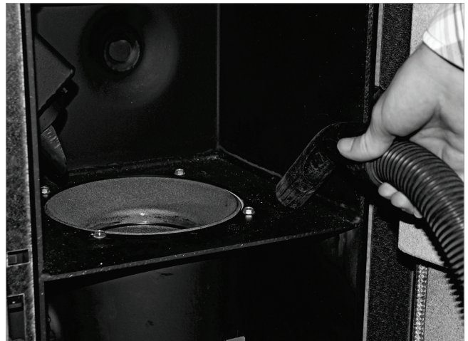
Abb. 143: Verbrennungsrückstände entfernen
