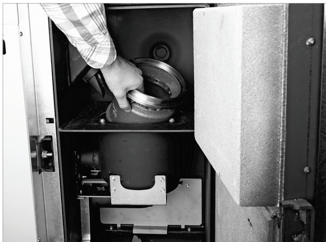
Abb. 145: Konus Unterteil herausheben
