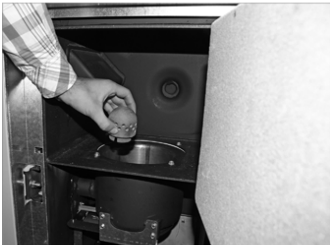
Abb. 149: Primärluftdorn entnehmen
