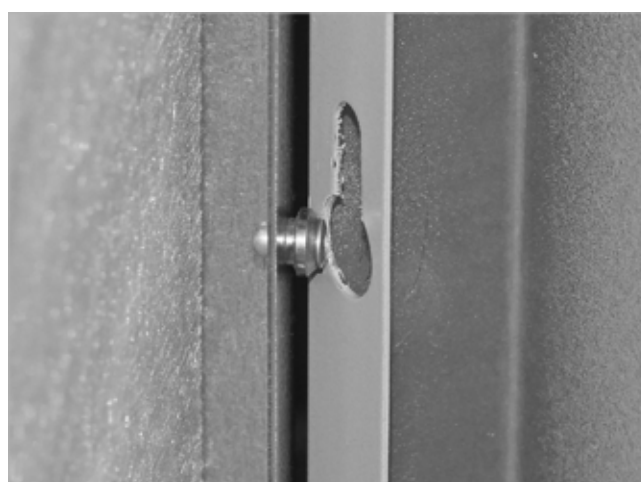
Abb. 86: Bajonettverschluss
