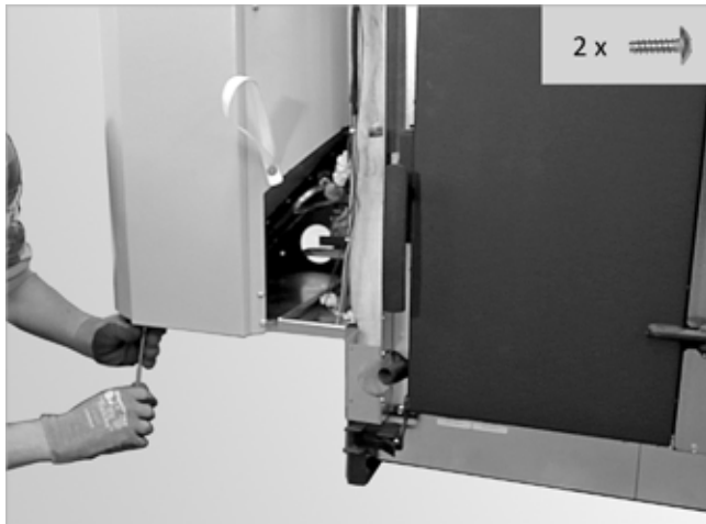
Abb. 168: Schrauben unten entfernen
