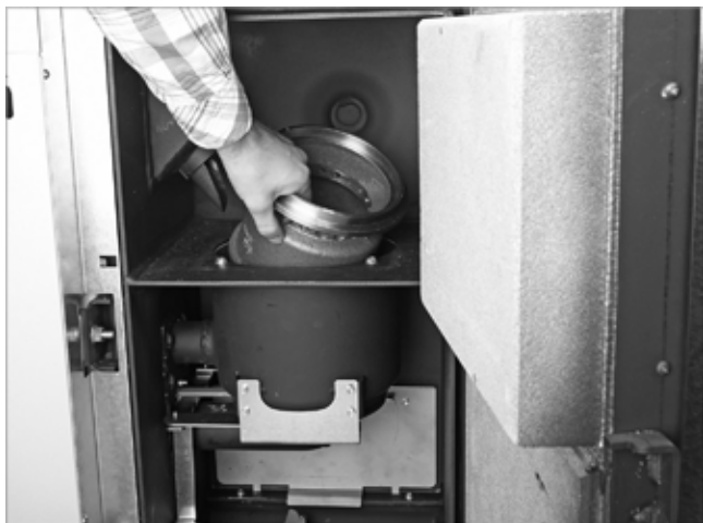
Abb. 145: Konus Unterteil herausheben
