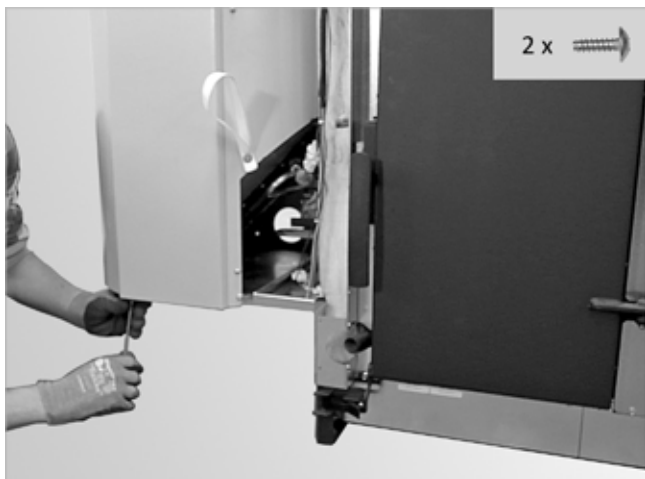
Abb. 39: Blende befestigen
