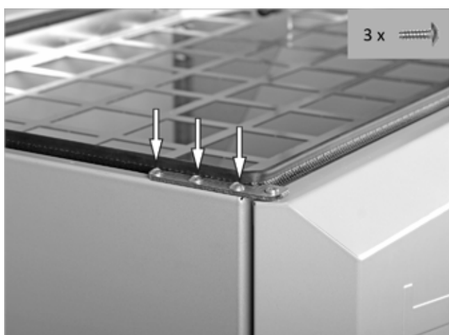
Abb. 83: Türscharnier anschrauben
