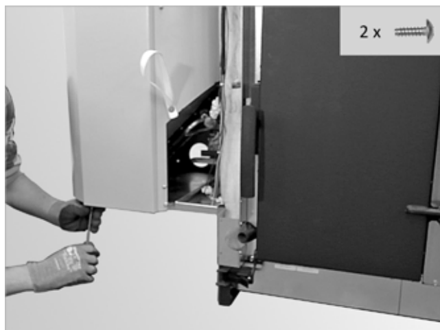
Abb. 31: Zwei Stück Schrauben entfernen
