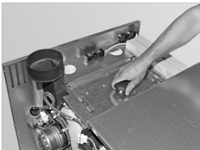
Abb. 18: Verschraubung entfernen
