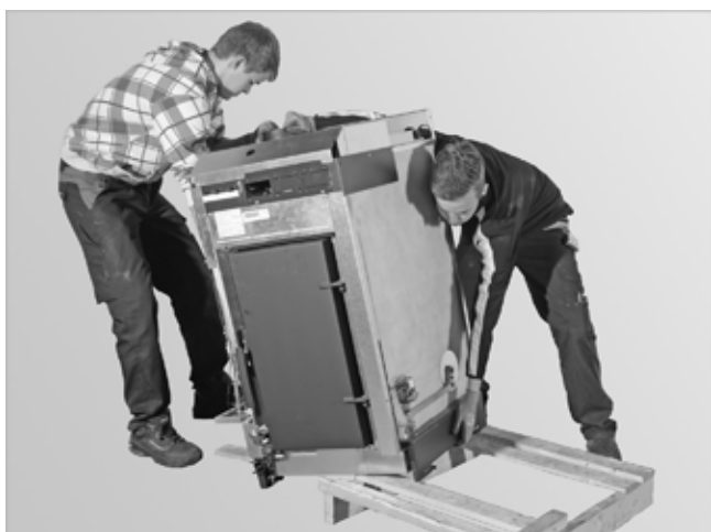
Abb. 9: Kessel von Palette schieben
