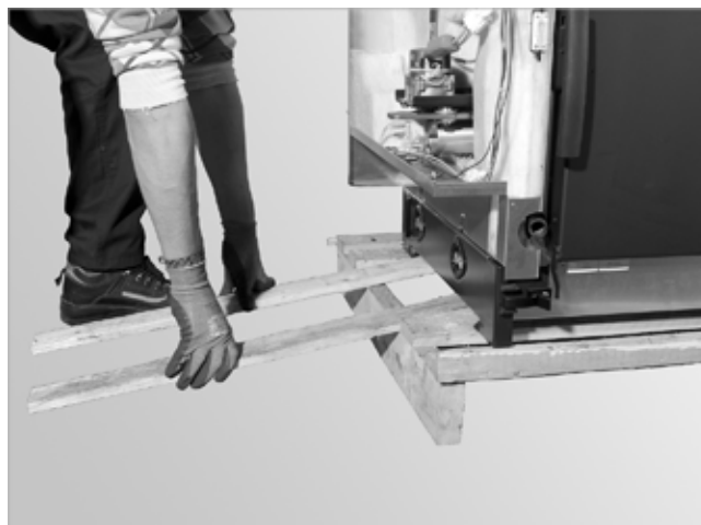
Abb. 7: Verschlagbretter an Rampe legen
