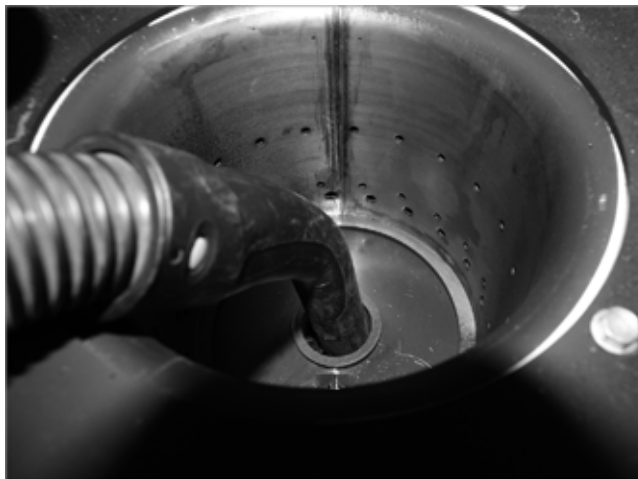
Abb. 152: Primärluftrohr aussaugen
