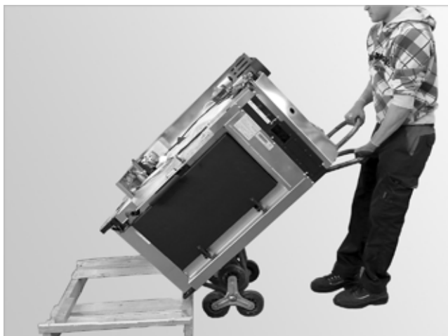
Abb. 11: Kessel von Palette heben
