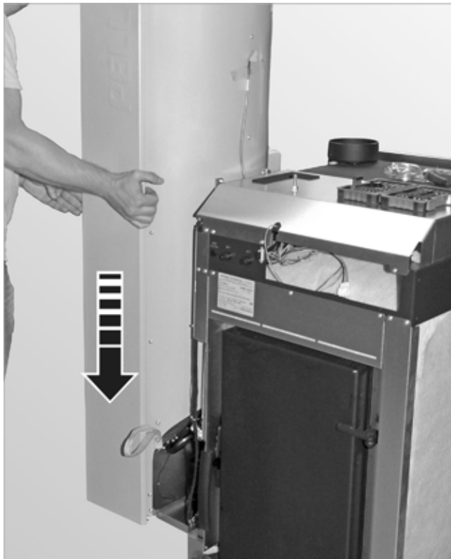
Abb. 169: Blende abnehmen (Bajonettverschluss)
