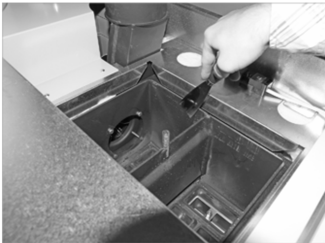
Abb. 160: Nachheizflächen reinigen
