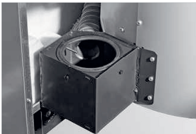
Abb. 8: Adapter befestigen
