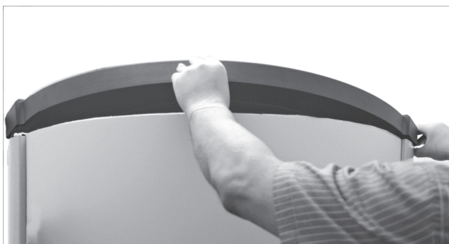
Afb. 11: bovenste afdekking plaatsen
