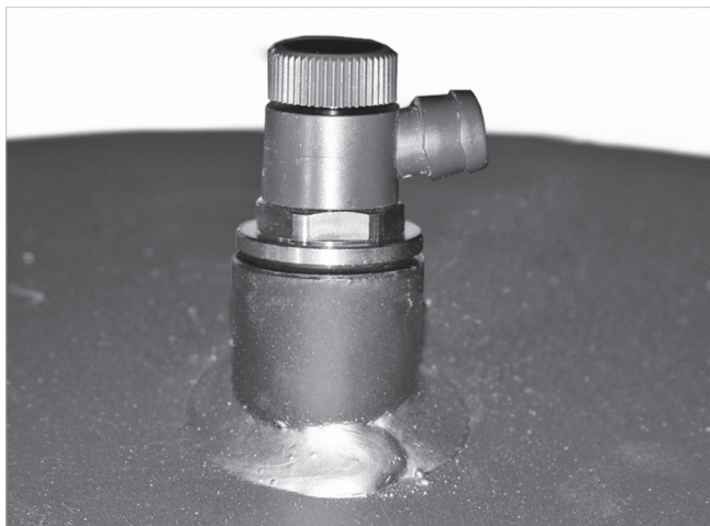
Afb. 4: handontluchter monteren
