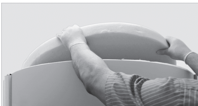
Afb. 10: ronde deksels plaatsen
