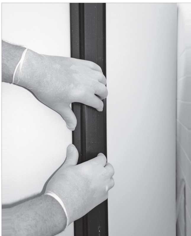
Afb. 8: isolatiegedeeltes sluiten
