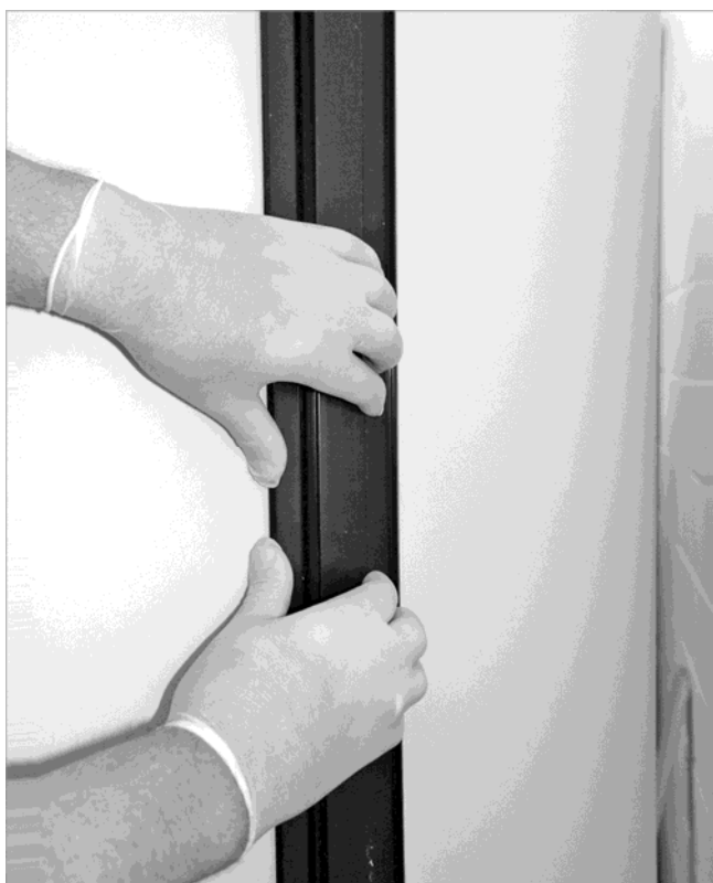
Afb. 8: isolatiegedeeltes sluiten
