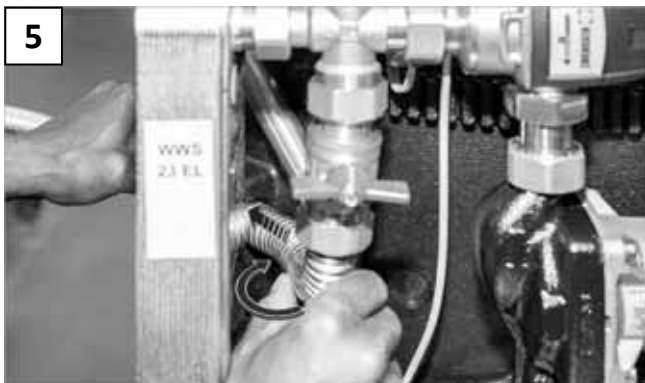
Schräg nach hinten biegen / Bend diagonally backwards / Piegare diagonalmente all'indietro / Doblar diagonalmente hacia atrás / Plier en diagonale vers l'arrière / Diagonaal naar achteren buigen
