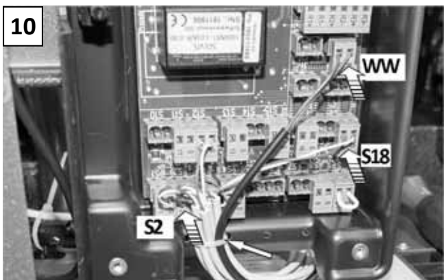
Aufstecken + Kabel sichern / Plug in + secure the cables / Inserire + fissare i cavi / Enchufar + asegurar los cables / Conecte + fixar os cabos / Brancher + fixer les câbles / Ansluiten + zet de kabels vast
