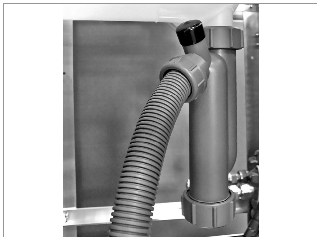
Abb. 14: Siphon mit Kondensatschlauch montieren
