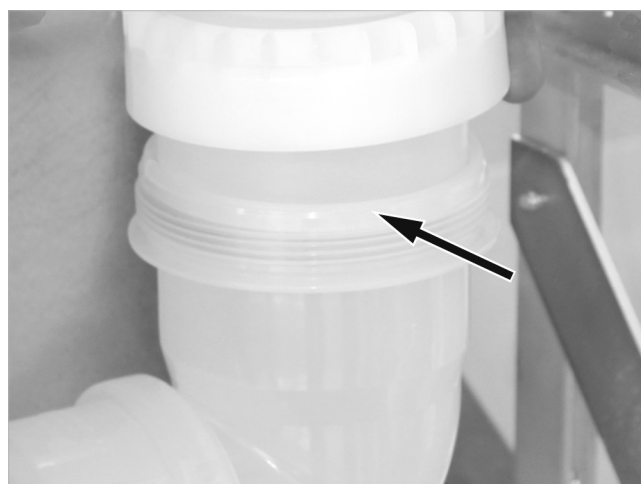
Abb. 12: Abgasbogen gerade ausgerichtet verschrauben
