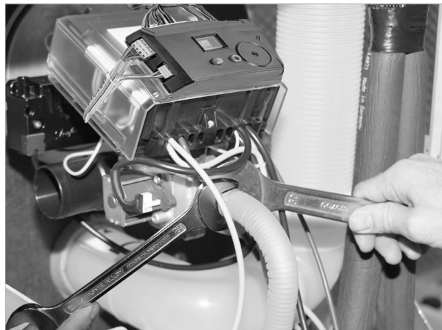
Abb. 7: Gasleitung anschließen
