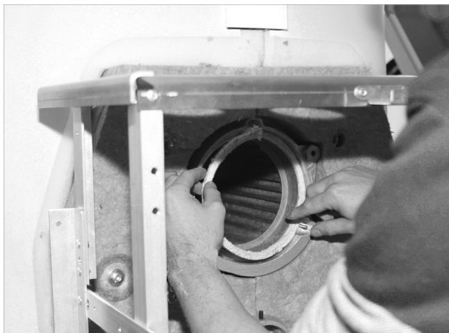
Abb. 5: Brennerdichtschnur einlegen, Stoß oben
