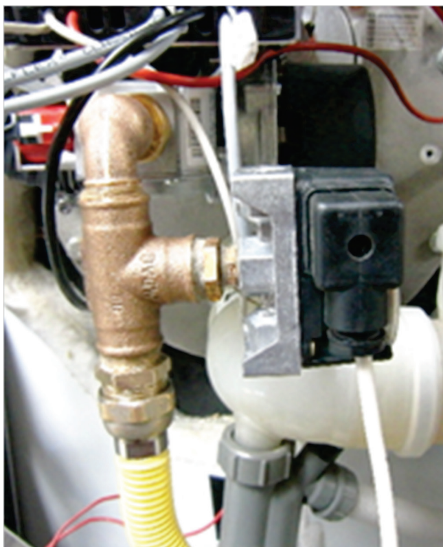
Abb. 1: Einbau Gasdruckwächter in Gasleitung
