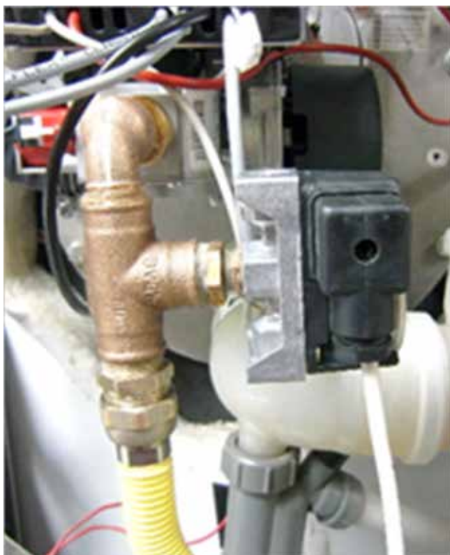
Abb. 1: Einbau Gasdruckwächter in Gasleitung
