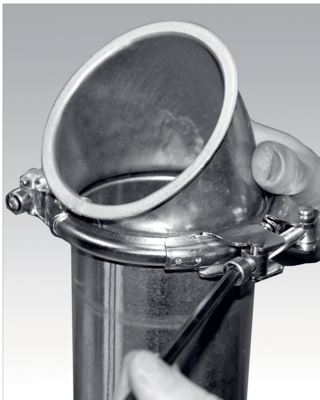
Abb. 117: Spannring montieren
