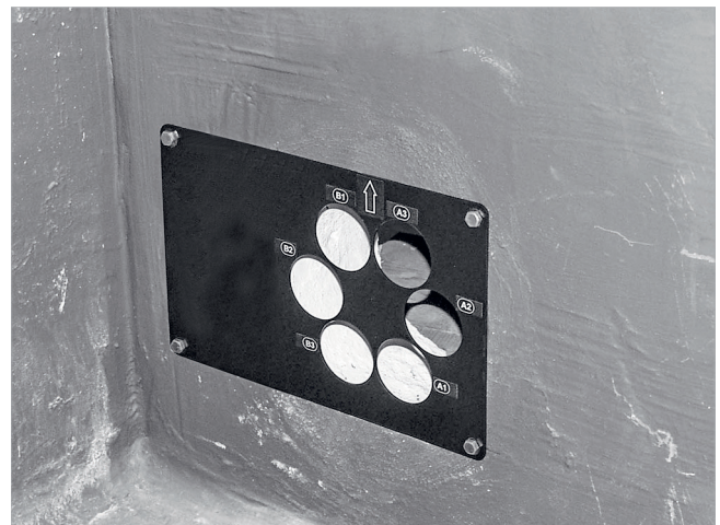
Abb. 18: Abdeckplatte im Lagerraum montiert
