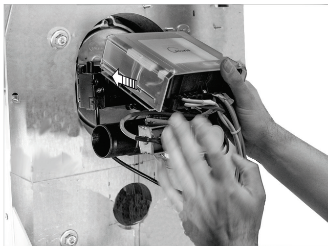
Fig. 28: Montaggio del bruciatore
