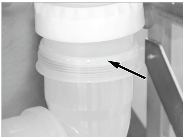
Fig. 63: avvitare e allineare in modo dritto la curva della tubazione fumi
