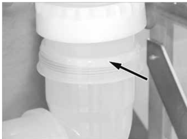
Fig. 39: avvitare e allineare in modo diritto la curva della tubazione fumi
