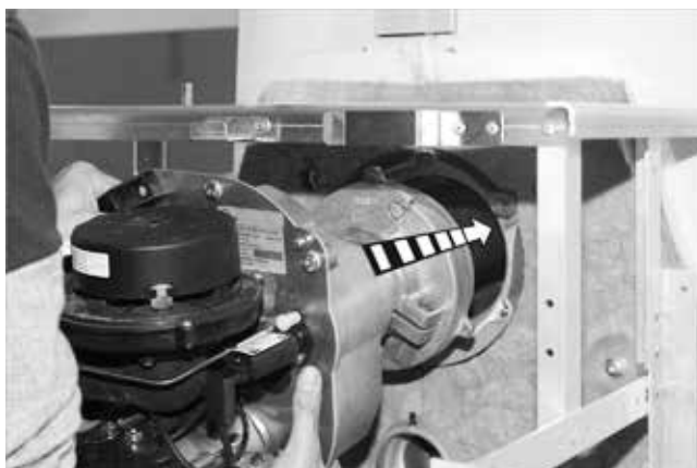
Fig. 55: Montaggio del bruciatore
