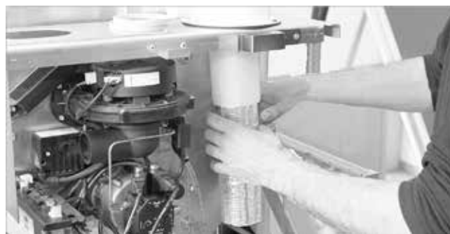
Fig.59: Montaggio fonoassorbente per la parte interna del tubo
