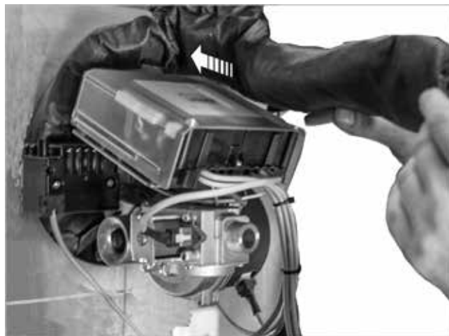
Fig. 29: Otturazione dell'incavo della flangia del bruciatore
