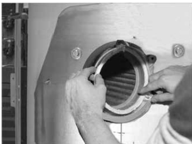
Fig. 26: Posizionamento del cordoncino di tenuta del bruciatore, a filo verso l'alto
