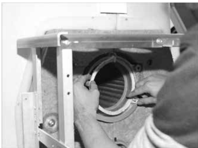
Fig. 49: posizionare il cordoncino di tenuta del bruciatore, a filo verso l'alto
