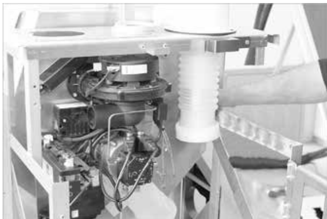
Fig. 61: Orientamento verso il basso del raccordo per lo scarico dei fumi
