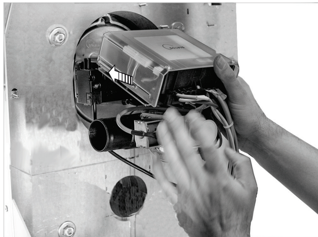
Fig. 28: Instalación del quemador
