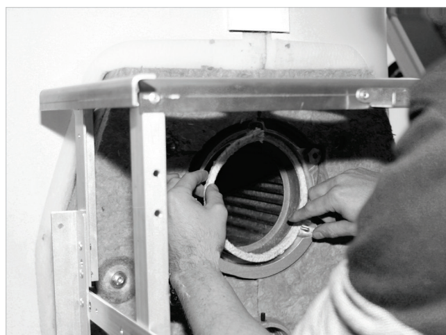
Fig. 49: Colocar el cordón de cierre hermético, extremo arriba
