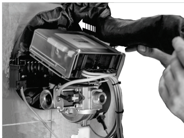
Fig. 29: Encajar en el espacio de la brida del quemador
