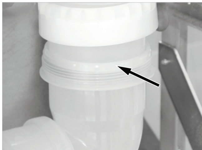
Fig. 39: Enroscar el codo de salida de humos alineado recto
