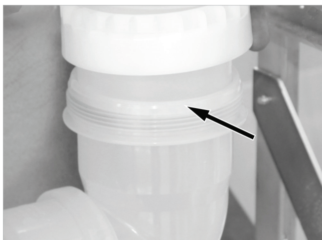
Fig. 63: Enroscar el codo de salida de humos alineado recto
