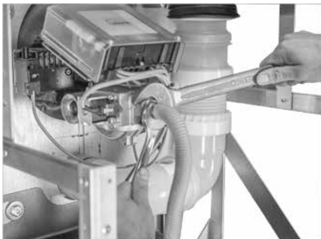
Fig. 43: Conectar la tubería de gas
