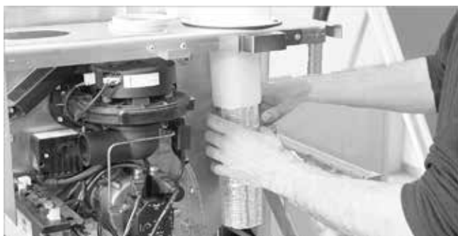
Fig. 59: Colocación del silenciador de tubo interior
