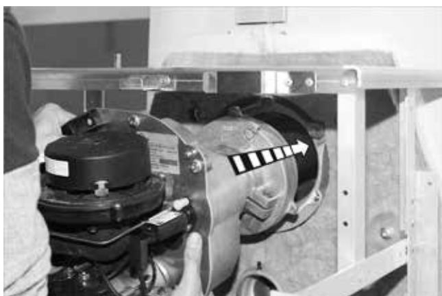
Fig. 55: Instalación del quemador
