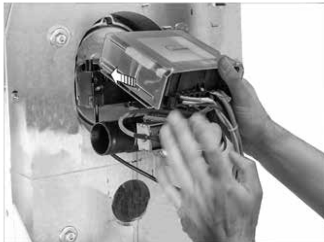
Fig. 28: Instalación del quemador
