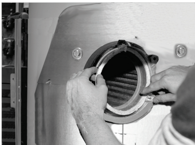
Fig. 26 : insérer le cordon d'étanchéité, joint vers le haut
