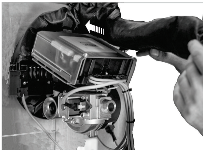
Fig. 29 : remplir la cavité au niveau de la bride du brûleur
