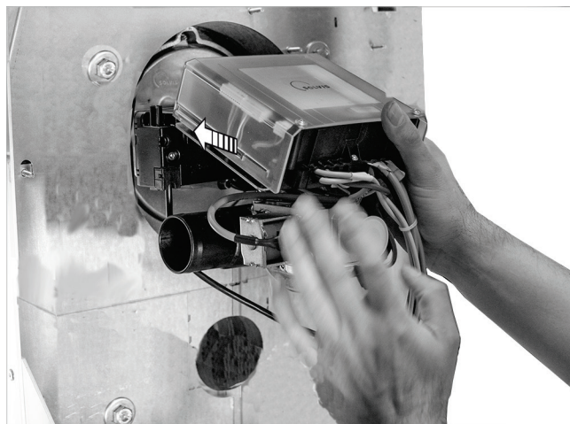
Fig. 28 : montage du brûleur
