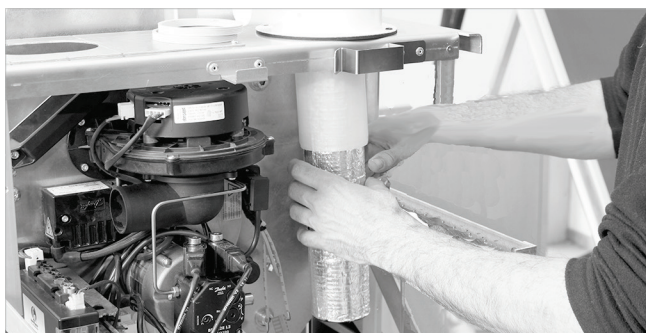
Fig. 59 : installation du silencieux du tuyau interne
