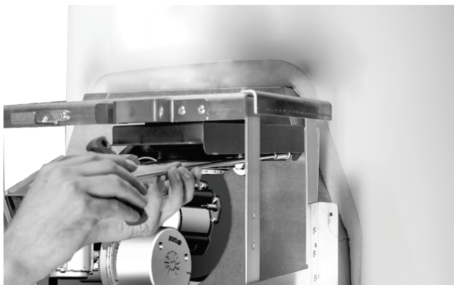
Fig. 34 : visser le support du soufflet d'étanchéité
