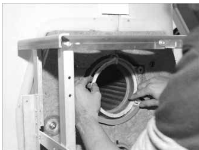
Fig. 49 : insérer le cordon d'étanchéité, joint vers le haut
