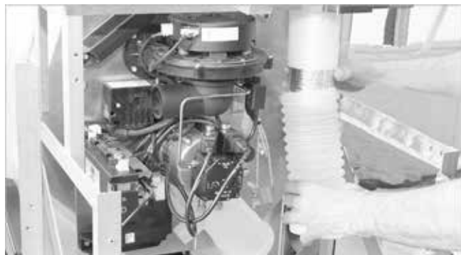
Fig. 60 : mise en place du raccord d'évacuation des gaz
