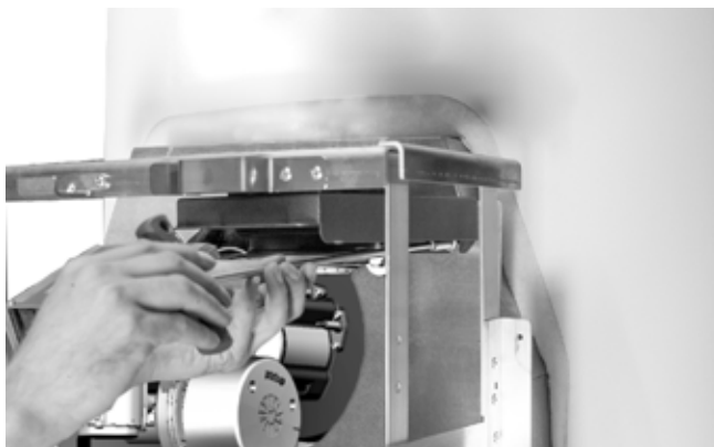
Fig. 34 : visser le support du soufflet d'étanchéité
