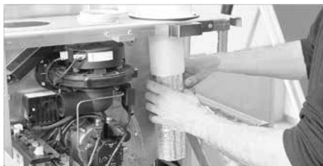
Fig. 59 : installation du silencieux du tuyau interne
