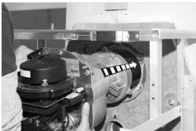
Fig. 55 : montage du brûleur
