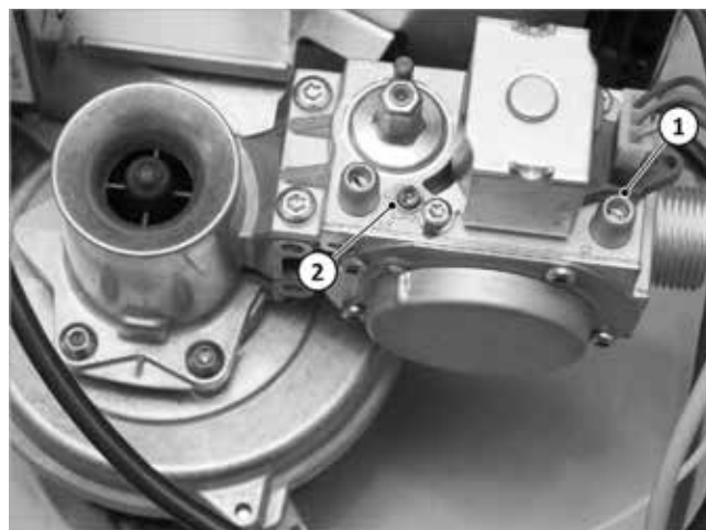
Fig. 97 : Réglage du brûleur
