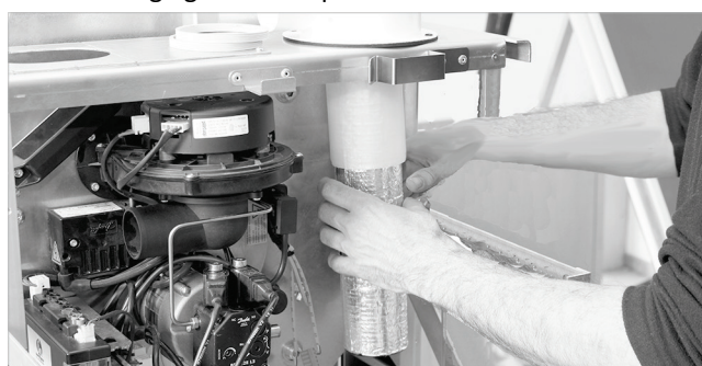
Afb.59: Inwendige geluiddemper plaatsen
