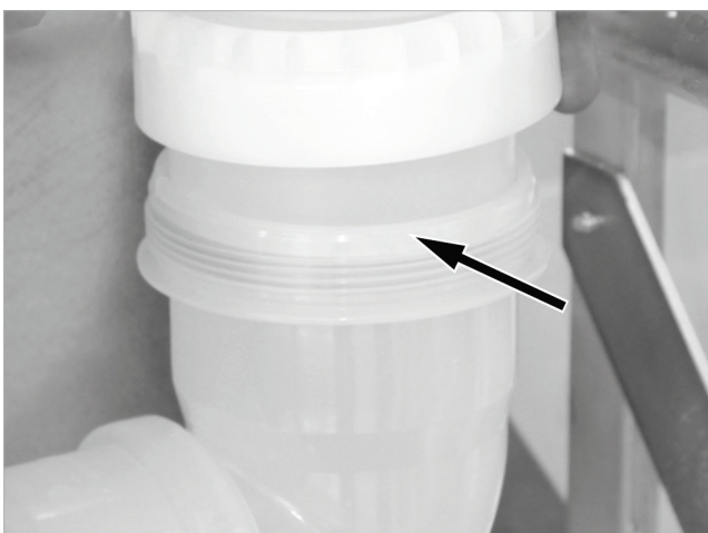
Afb. 63: De rookgasbocht recht uitgelijnd vastschroeven
