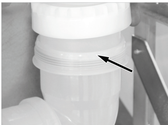
Afb. 39: De rookgasbocht recht uitgelijnd vastschroeven
