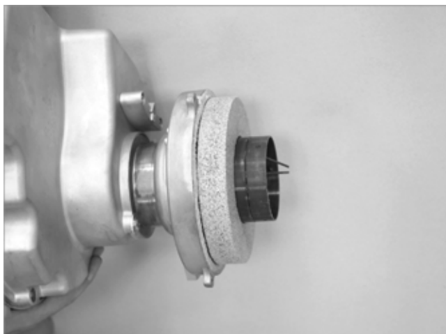
Afb. 53: Ketel deurisolatie plaatsen
