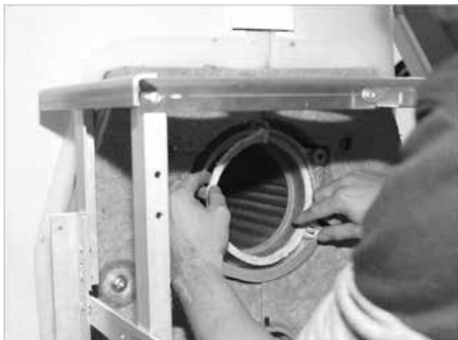
Afb. 49: Branderpakkingsnoer plaatsen, kopse kanten boven
