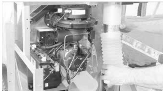
Afb.60: Rookgasaansluitstuk opsteken
