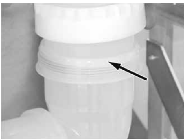
Afb. 63: De rookgasbocht recht uitgelijnd vastschroeven
