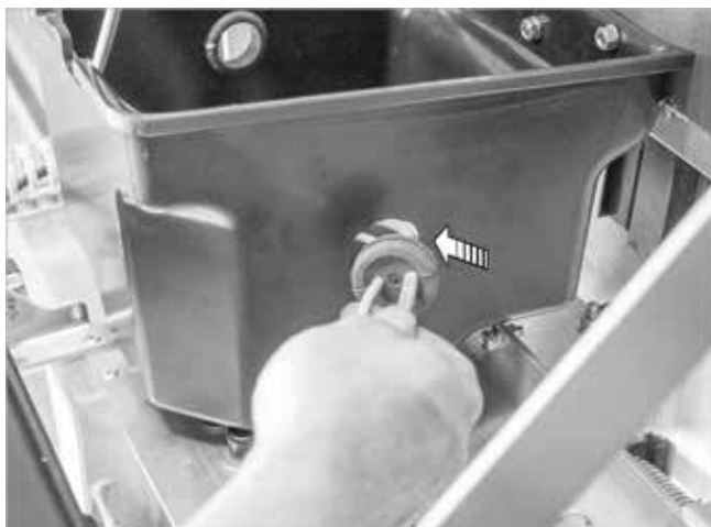
Afb. 32: Branderkabel luchtdicht doorvoeren
