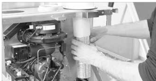
Afb.59: Inwendige geluiddemper plaatsen
