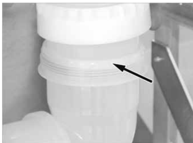
Afb. 39: De rookgasbocht recht uitgelijnd vastschroeven
