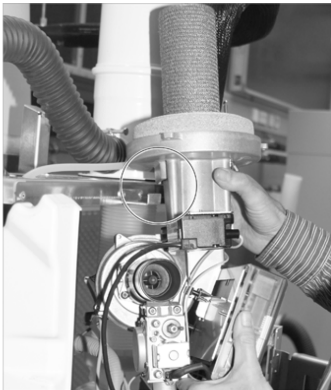
Afb. 109: Brander in onderhoudspositie aan de console
