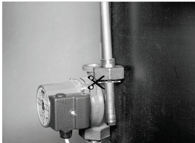
Abb. 4: Heizungsrücklaufrohr passend ankürzen
