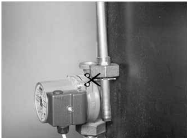
Abb. 4: Heizungsrücklaufrohr passend ankürzen
