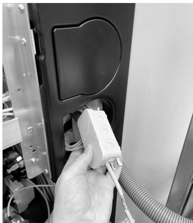
Abb. 17: Kabel und Modbusanschlussbox durchstecken
