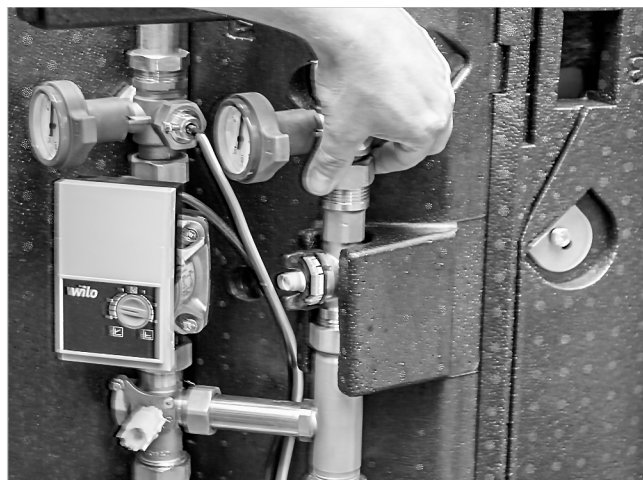
Abb. 8: HKS-Rücklaufstrang oben montieren
