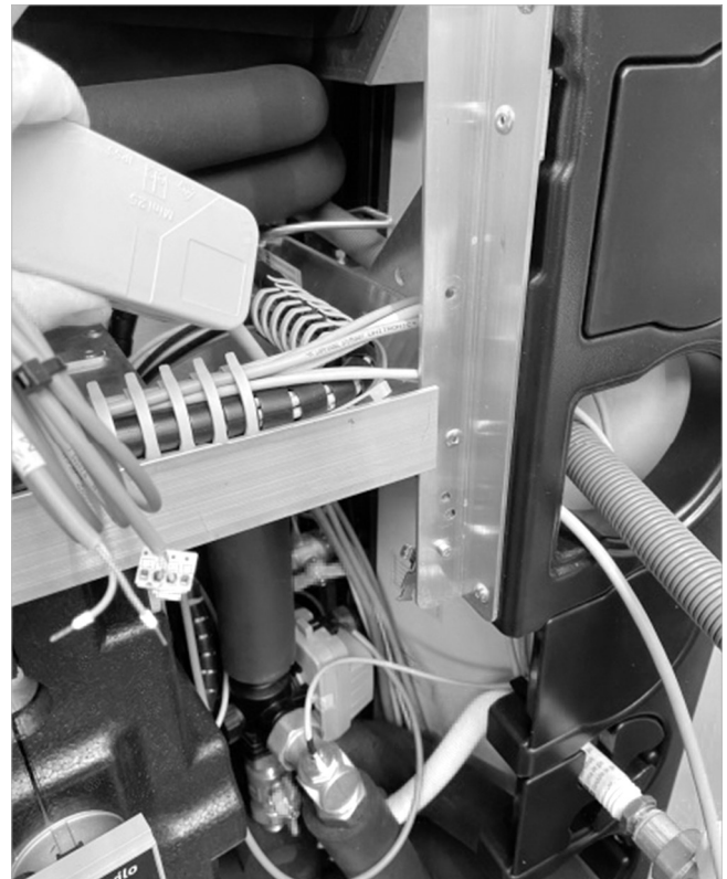
Abb. 20: Modbusanschlussbox nach oben führen
