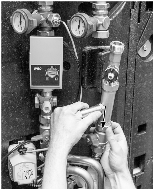
Abb. 6: HKS-Rücklaufstrang unten montieren
