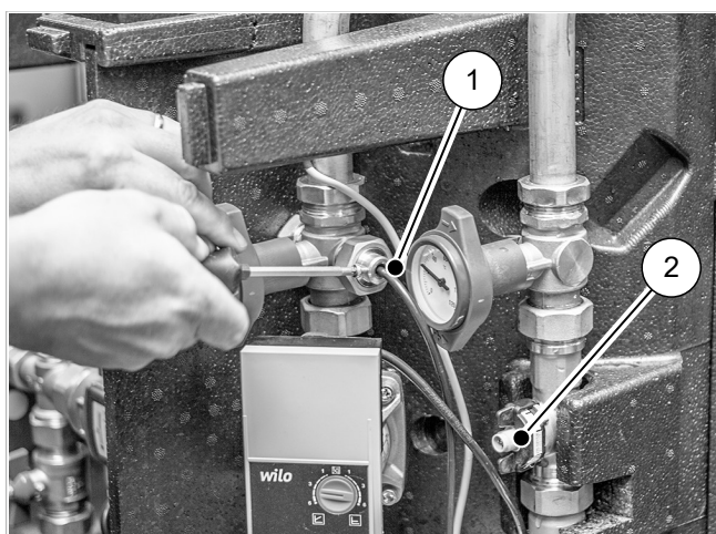
Abb. 12: Vorlauf-Sensor WME fixieren
