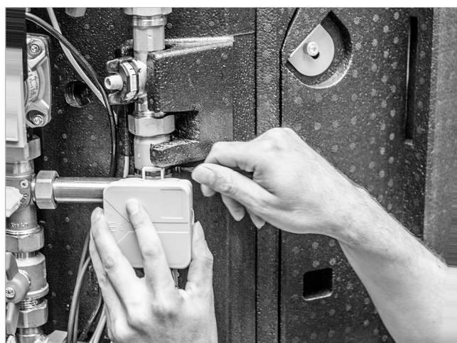
Abb. 9: Elektronikbox befestigen
