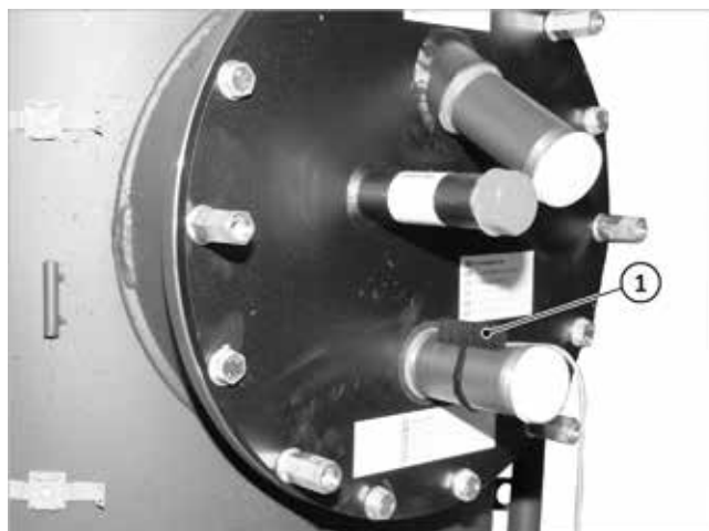
Fig. 4: Sensore S4 (1) montato
