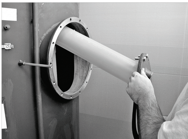
Fig. 3: Colocación de la tapa de brida
