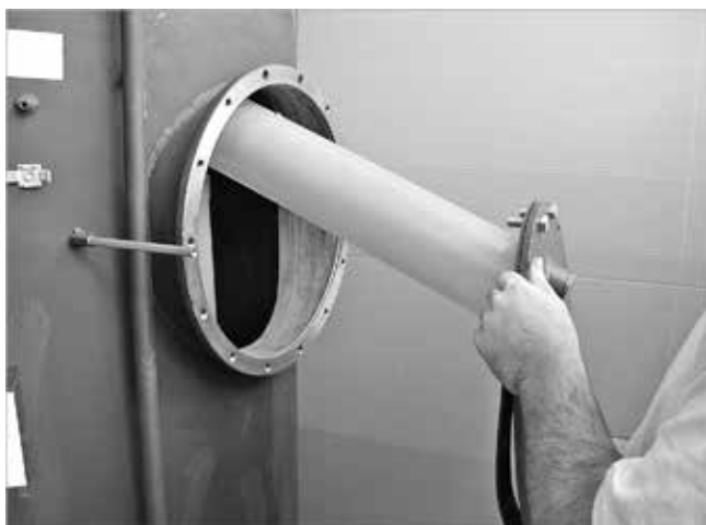
Fig. 3: Colocación de la tapa de brida
