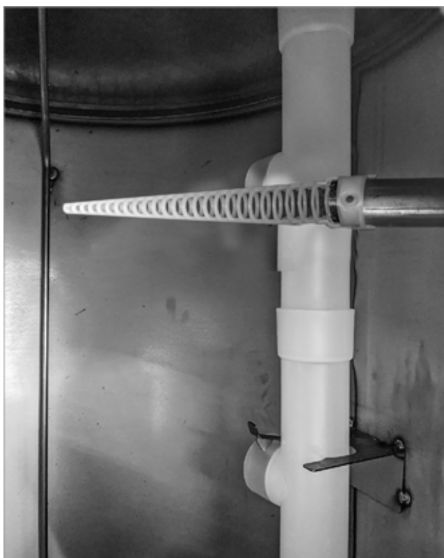
Fig.16 : lance de chargement sur le tuyau aller
