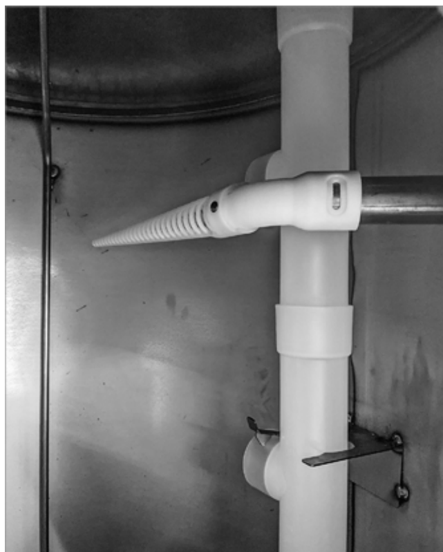
Fig.18 : lance de chargement avec coude
