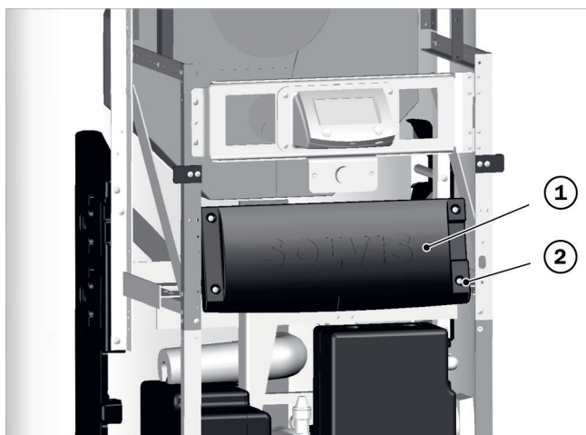
Afb. 19: Deksel van de netwerkkaart bevestigen
