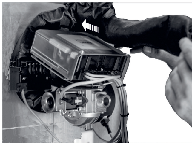
Fig. 33: Otturazione dell'incavo della flangia del bruciatore
