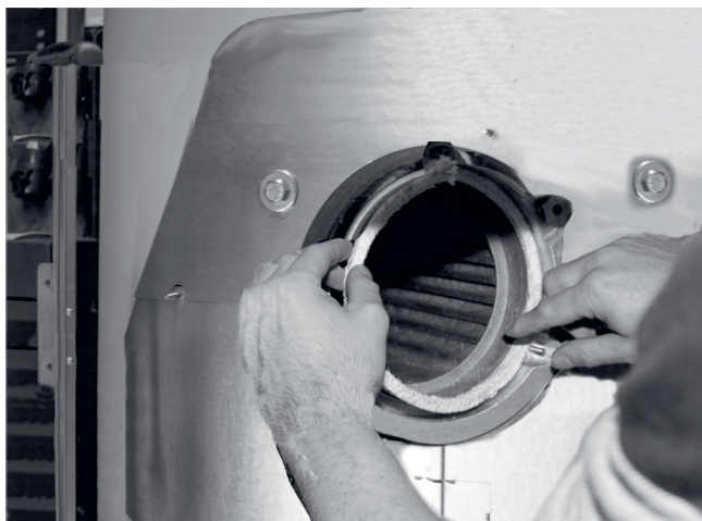
Fig. 30: Posizionare il cordoncino di tenuta del bruciatore, a filo verso l'alto
