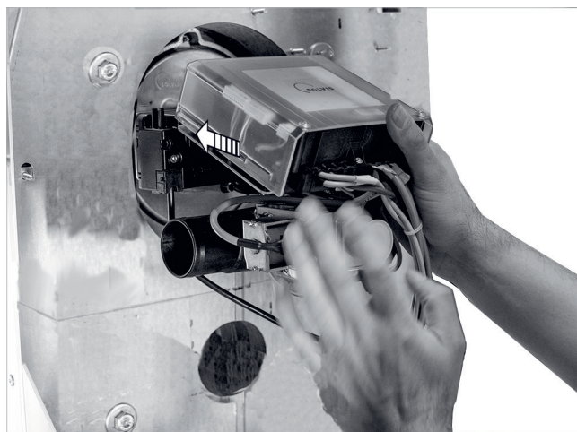
Fig. 32: Montaggio del bruciatore
