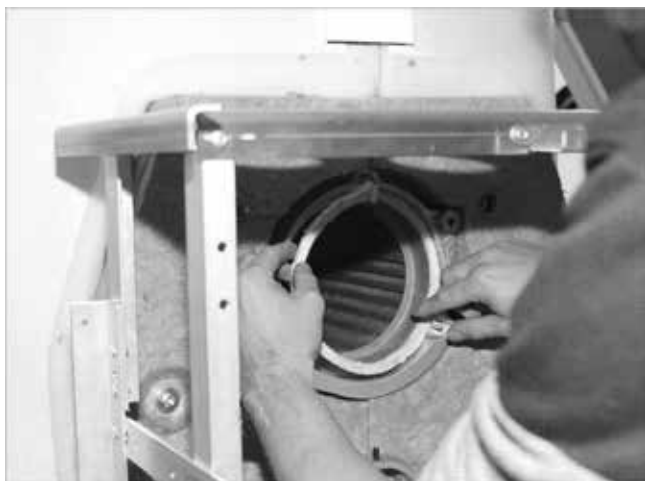
Fig. 53: Posizionare il cordoncino di tenuta del bruciatore, a filo verso l'alto
