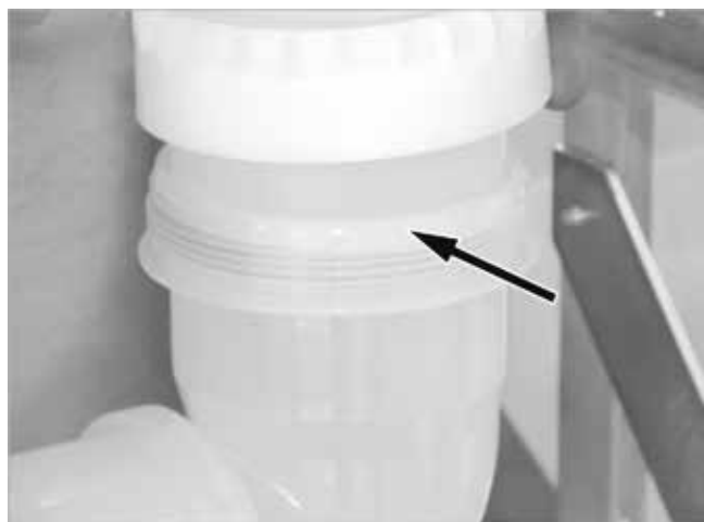
Fig. 66: avvitare e allineare la curva della tubazione fumi
