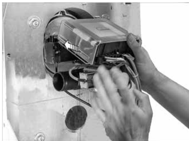
Fig. 32: Montaggio del bruciatore
