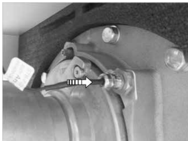
Fig. 72: inserire e avvitare eSTB
