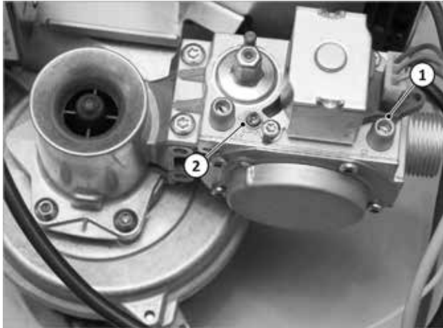
Fig. 103: impostazione del bruciatore
