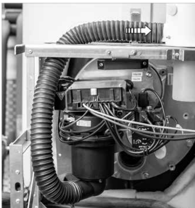
Fig. 60: Montaggio del tubo flessibile per l'aria di alimentazione
