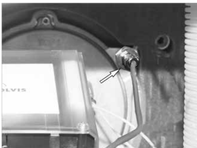
Fig. 115: inserimento dell'eSTB
