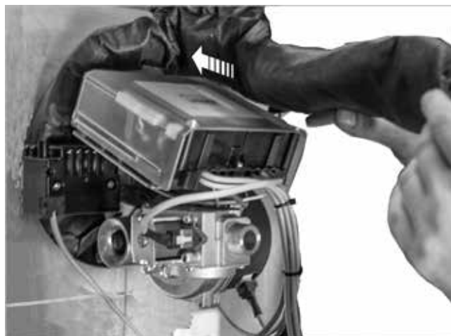
Fig. 33: Otturazione dell'incavo della flangia del bruciatore
