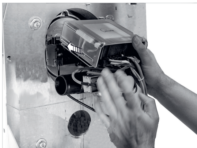
Fig. 32: Instalación del quemador
