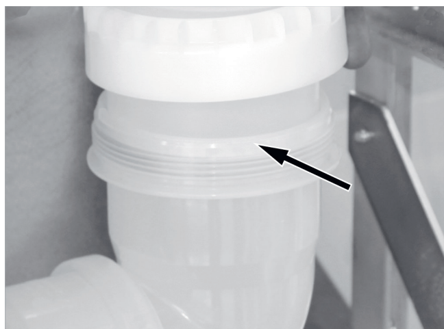
Fig. 43: Enroscar el codo de salida de humos alineado recto
