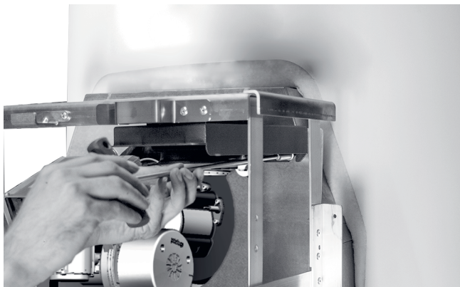
Fig. 38: Atornillar el soporte del fuelle de estanqueidad
