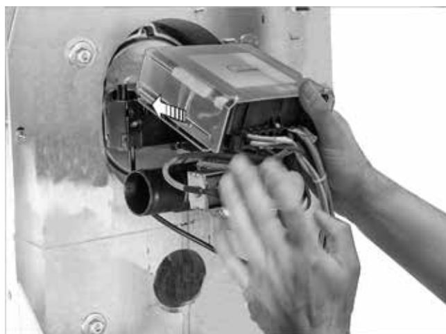
Fig. 32: Instalación del quemador
