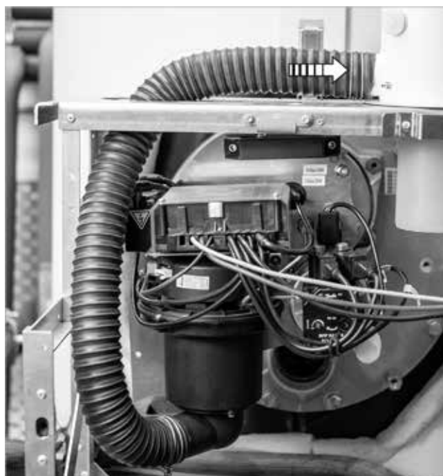
Fig. 60: Montaje del tubo de entrada de aire
