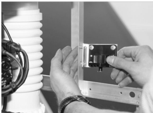
Fig. 67: Fijación del soporte del filtro de gasóleo
