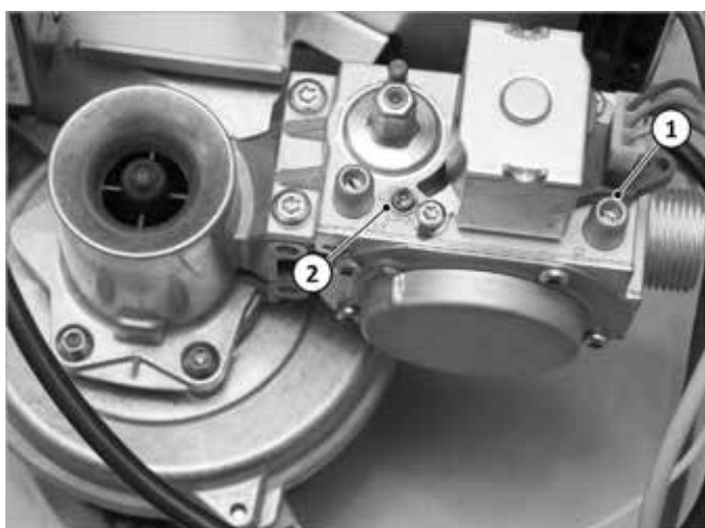
Fig. 103: Ajuste del quemador
