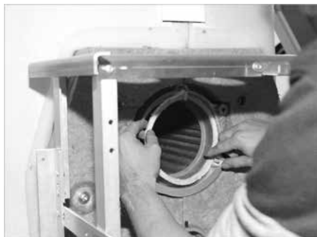
Fig. 53: Colocar el cordón de cierre hermético, extremo arriba
