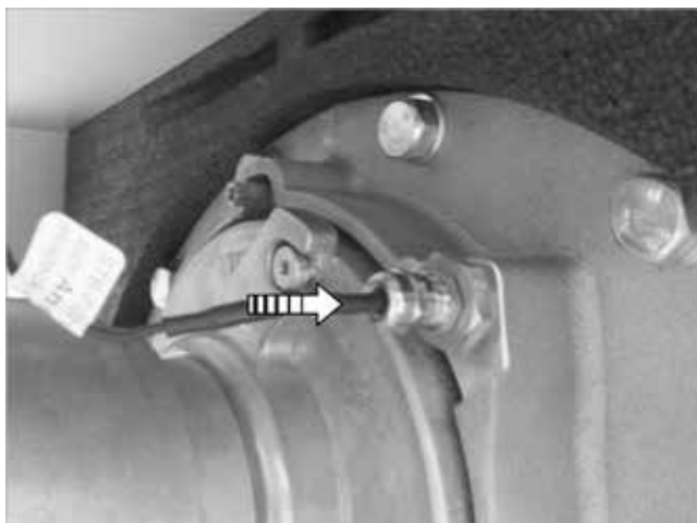
Fig. 72: Inserción y atornillado del eSTB
