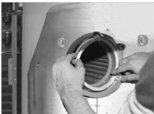
Fig. 30: Colocar el cordón de cierre hermético, extremo arriba
