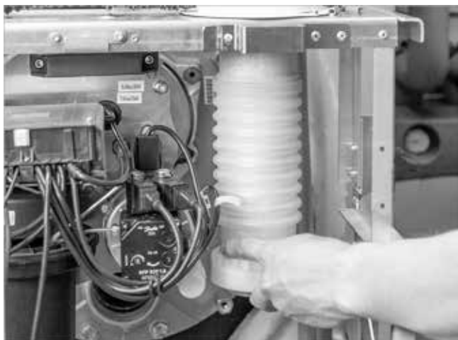
Fig. 64: Alineación recta de la pieza de tubo de conexión de salida de humos
