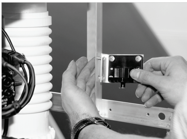
Fig. 66 : fixation du support du filtre à fioul
