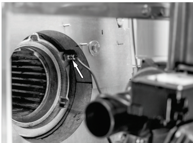
Fig. 30 : insertion de l'eSTB
