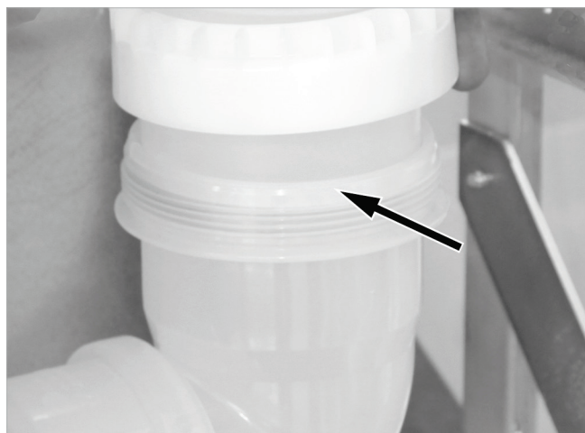
Fig. 42 : vissage du coude d'évacuation des gaz à la verticale
