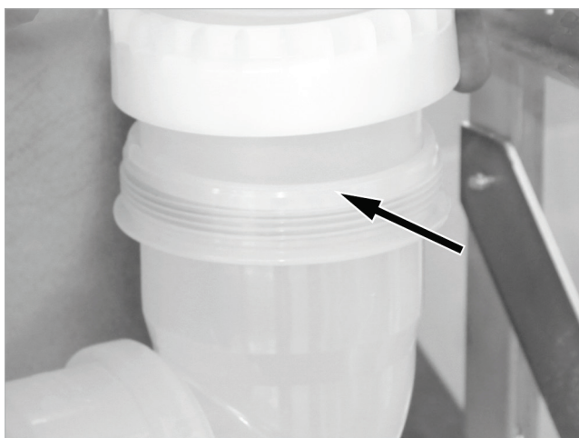
Fig. 65 : vissage du coude d'évacuation des gaz à la verticale
